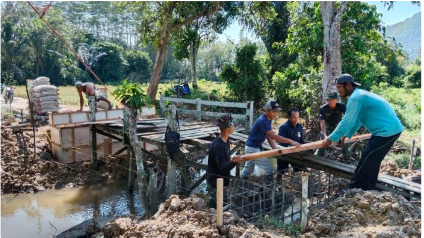
Progres Pengerjaan Jembatan, Satgas TMMD Cor Abutment
